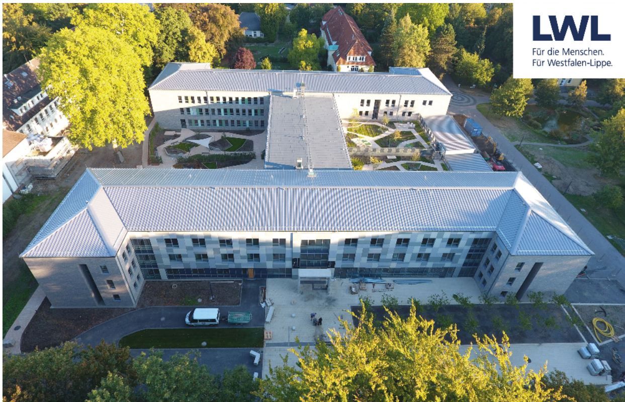
Blick auf das neue Hauptgebäude der LWL-Klinik Münster
